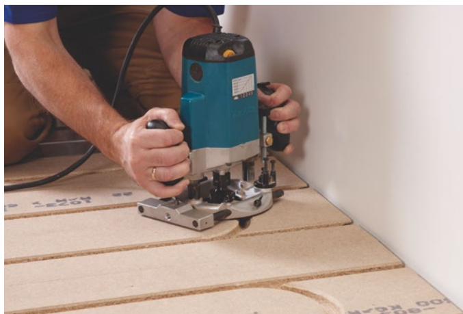
Figur 7 Fräsning av vändspår i varannan rad.
